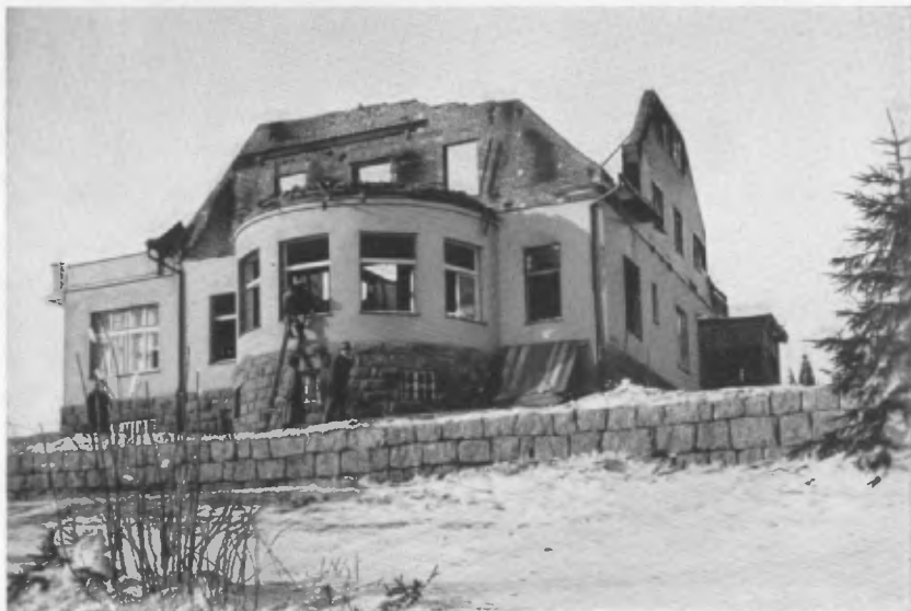
Lichtbild von Heinrich Walter. Brandstelle der Weberbergbaude.
