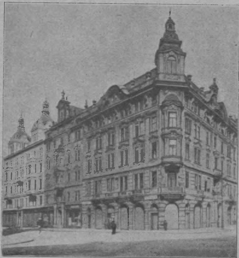
GEBÄUDEBESITZ MIT DER HAUPTKELLEREI.
