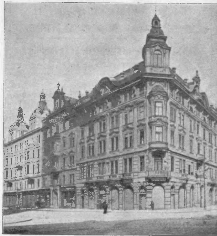
GEBÄUDEBESITZ MIT DER HAUPTKELLEREI.
