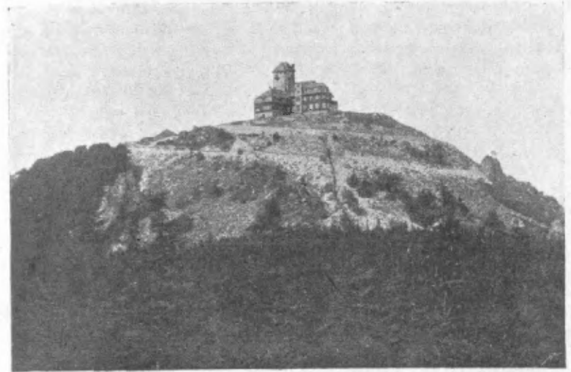
Der Rohrgraben auf der Koppe.
