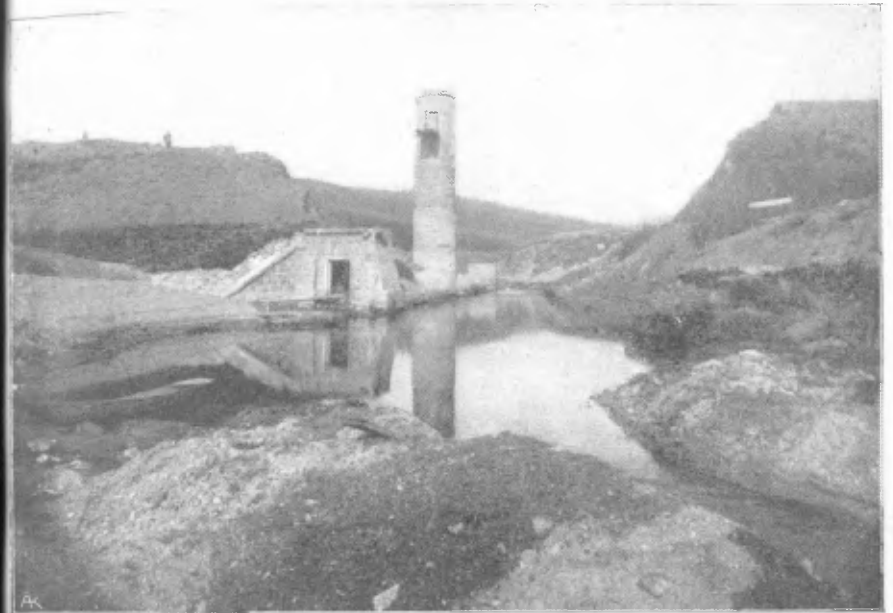
1. Damnbruchstelle von unten gesehen.
