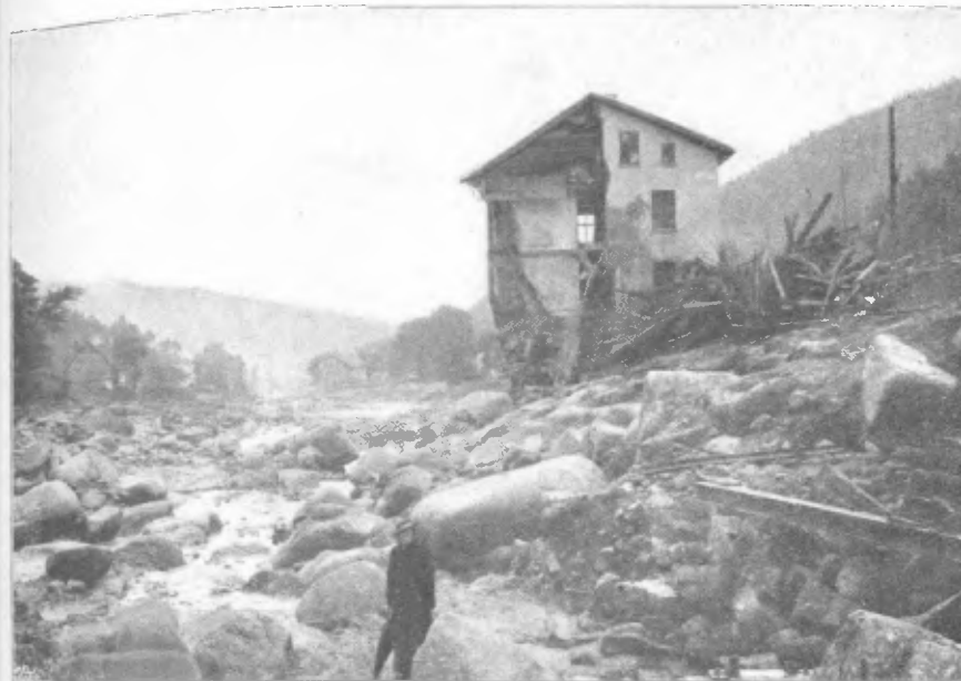
5. Arbeiterhaus der Fabrik Mann nach dem Dammbbruch.
