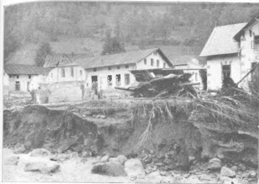
7. Am sinken Ufer der Desse.
