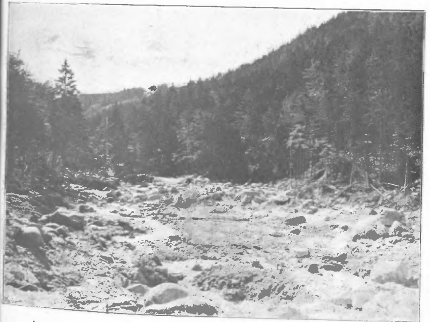
4. Die Stelle der Säge und des Hegerhauses nach dem Dammbbruch.
