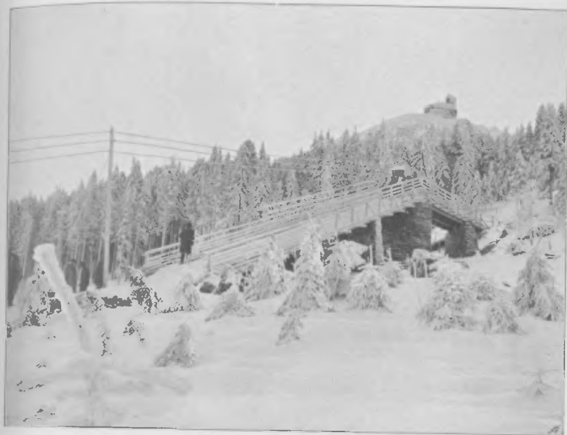
Obere Koppelbrücke mit Kuppe.
