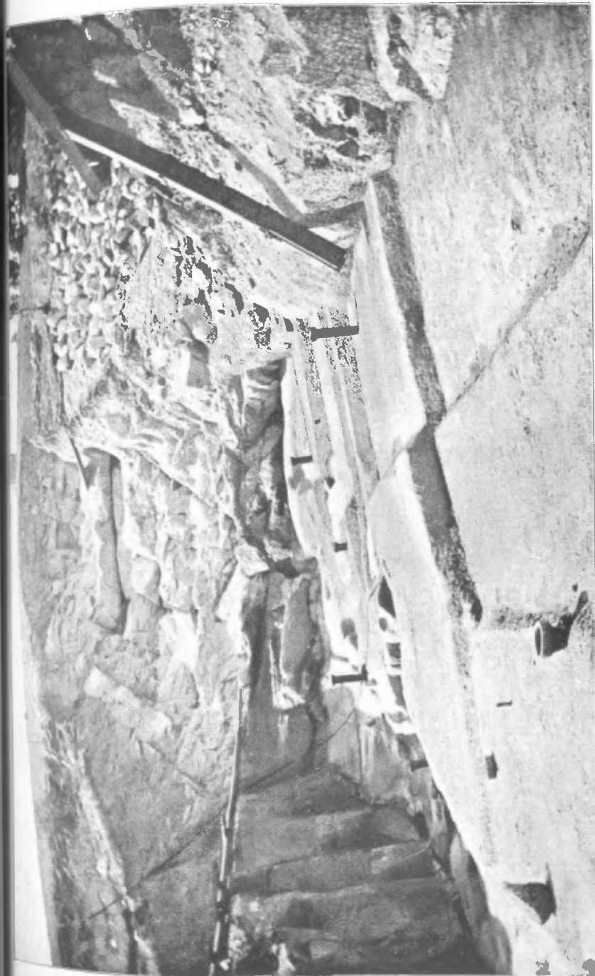
Betonfundament der Voigtsbacher Talsperre.
