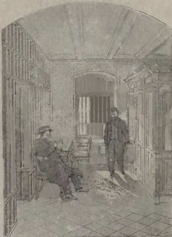
Aufsicht des Vor-Tresors.
