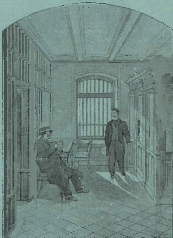
Ansicht des Vor-Tresors.
