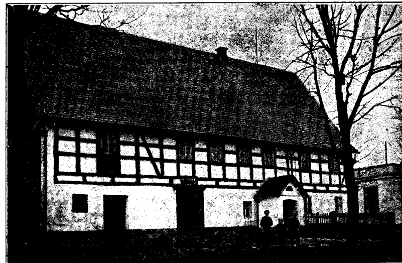
Haus Nr. 175 neu, 155 alt in Schönwald bei Auffig. erbaut 1776 von Joh. Franz Umlauf.
