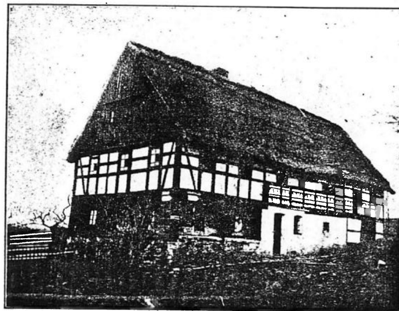
Das Haus Nr. 18 in Deutschkahn.
